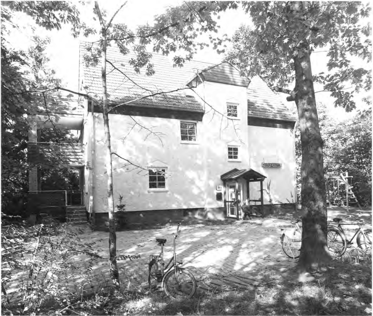
Jugendzentrum Holzhaus der evangelischen Kirchengemeinde Schönow Pfarrlandstr. 26 1000 Berlin 37 Neuerbaut 1984
