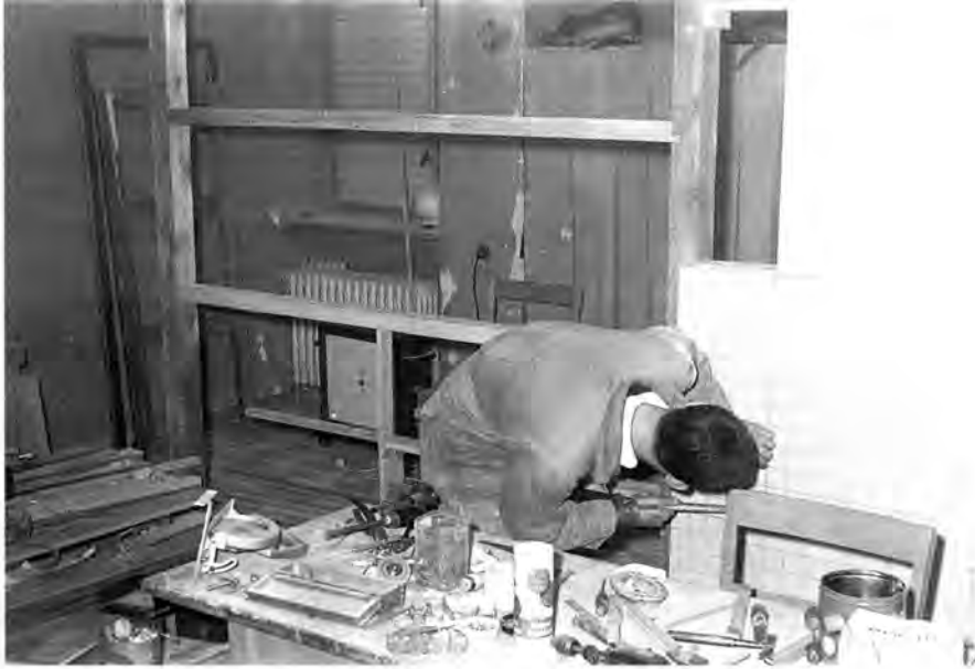
Ausbau des Tonstudios
